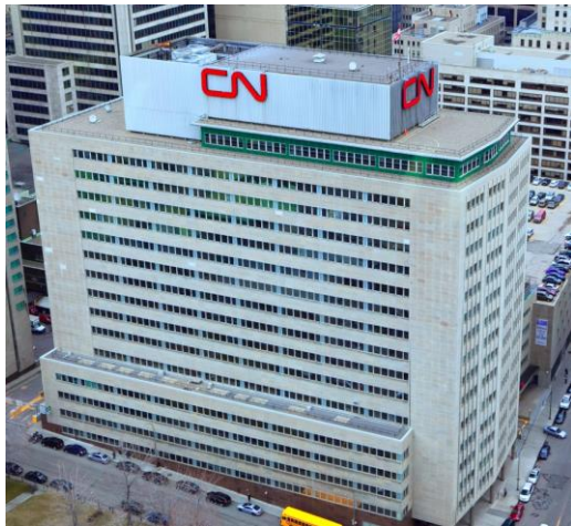
Gare centrale de Montréal 1 726 000 pi 2
