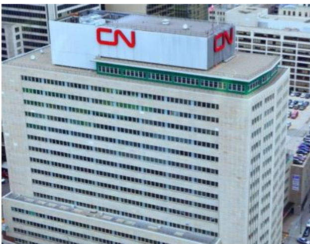
Gare Centrale – Montréal 649 000 pi 2 (portion bureau)
